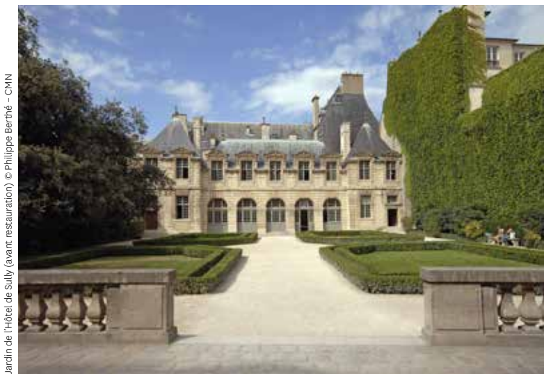
Jardin de l'Hôtel de Sully (avant restauration) © Philippe Berthé - CMN
