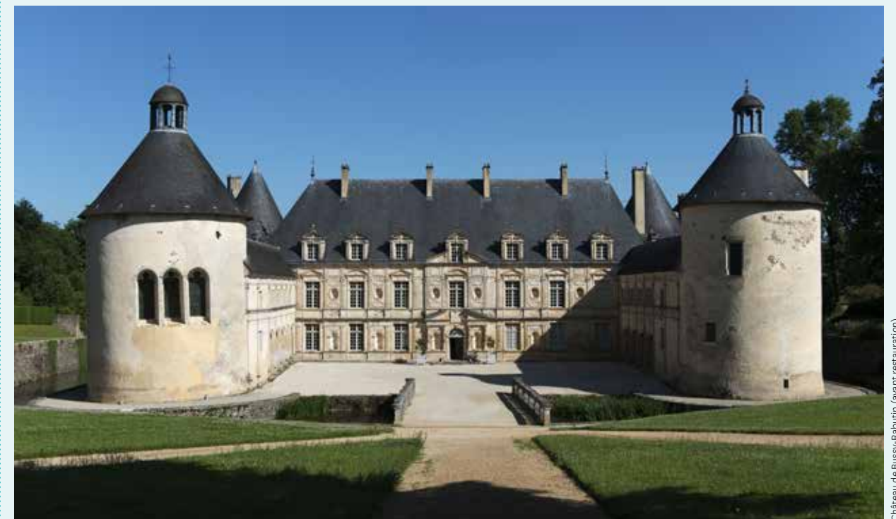
Château de Bussy-Rabutin (avant restauration) © Colombe Clér - CMN
