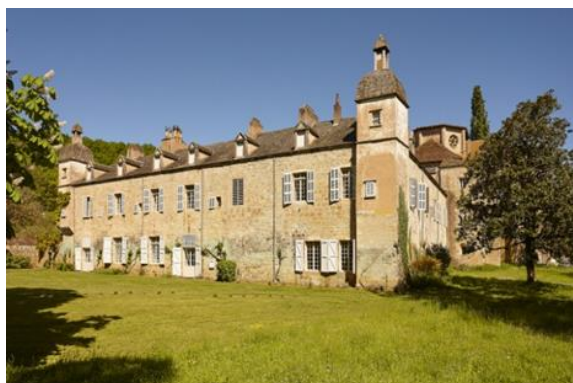
Abbaye de Beaulieu-en-Rouergue, logis abbatial avant restauration © Laurent Lecat - CMN
